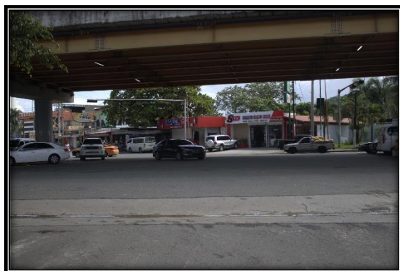
Foto 23: Cruce de Piedra Blanca.
