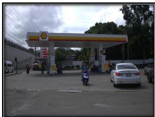
Foto 26: Estación de Combustible Cruce de Piedra Blanca
