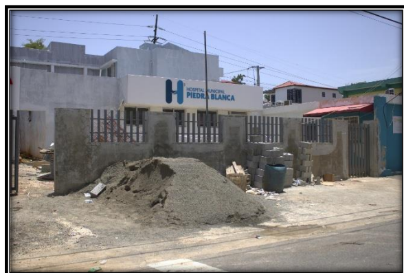
Foto 12: Hospital Municipal de Piedra Blanca
